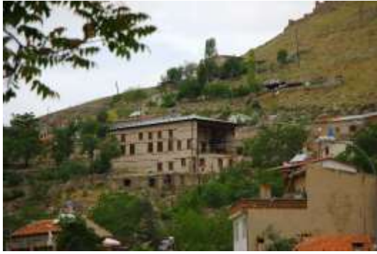
Şekil 56: Mezaryaka Camii güney cephesi. (M.Şamil ÖZYURT – 2018)
