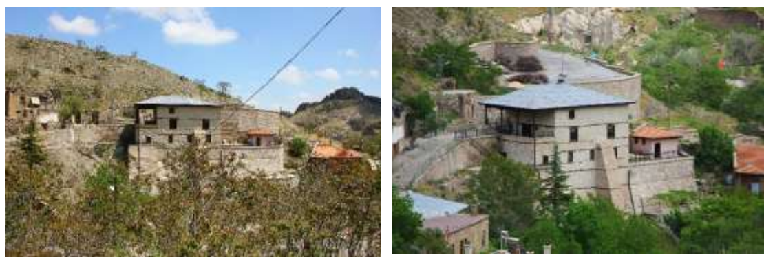
Şekil 48: Mormi Camii batı cephesi. (M.Şamil ÖZYURT – 2018)
